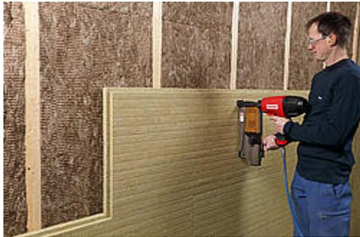
Druckfeste, nicht brennbare Dämmplatte, allseitig mit Nut und Kamm. Vollflächige Dämmschutzschicht bei hinterlüfteten Fassaden, direkt in den Holzständer geklammert.
